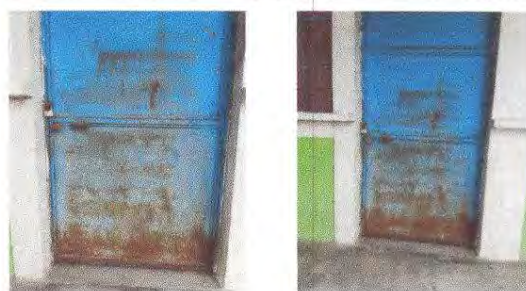
Foto 2: Mantenimiento a estructura( lijado, aplicación de pintura)
