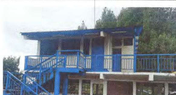
Foto 4: Sustitucion de canales y bajada de agua pluvial
