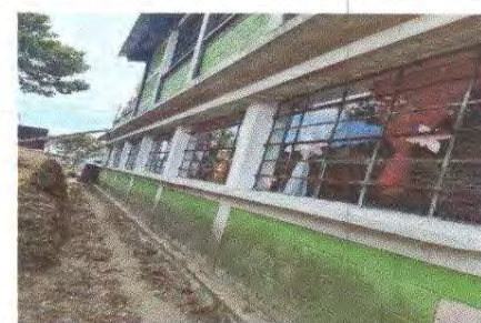
Foto 6: Pintura en muros exteriores e interiores
