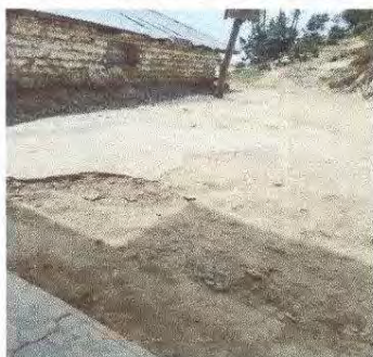
Foto 3: Reparacion de torta de concreto
