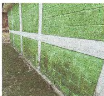
Foto 5: Pintura en muros exteriores e interiores
