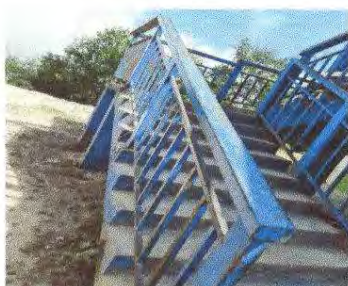
Foto 9: Mantenimiento a barandas
