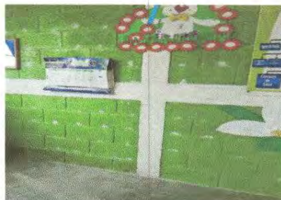
Foto 14: Repello en muro
