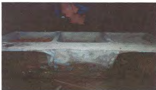
Foto 13: Sustrucion de pila de cemento de dos lavadero
