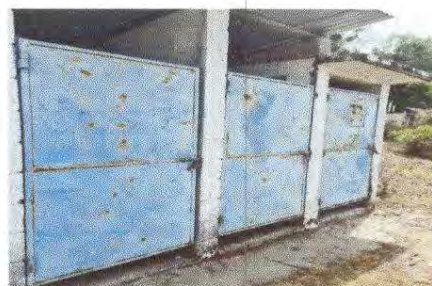
Foto 8: Mantenimiento a estructura( lijado, aplicación de pintura)
