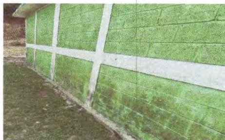
Foto 15: Repello en muro
