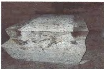
Foto 17: reparacion de plancha
