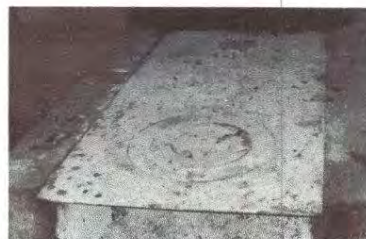
Foto 18: reparacion de plancha
