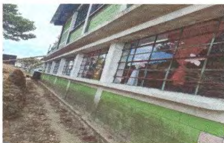
Foto 15: Repello en muro
