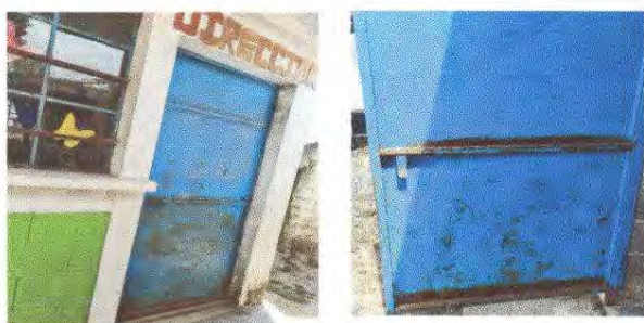
Foto1: Mantenimiento a estructura( lijado, aplicación de pintura)
