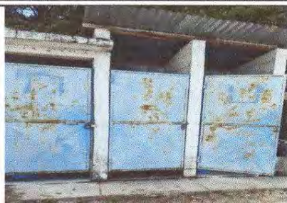
Foto 7: Mantenimiento a estructura( lijado, aplicación de pintura)
